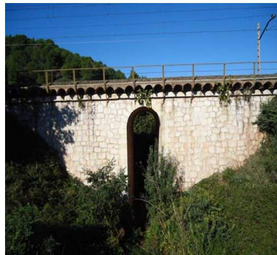
Obra de pas sota línia ferrocarril
