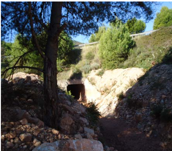
Esquerra Obra de pas sota la C-14
