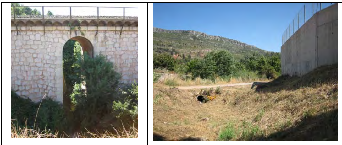
Figura 2 Extrems aigües amunt del domini d'estudi (obra de pas sota línia ferrocarril esquerra). I extrem aigües avall (camí rústic d'accés a les parcel·les de cultiu, dreta)
