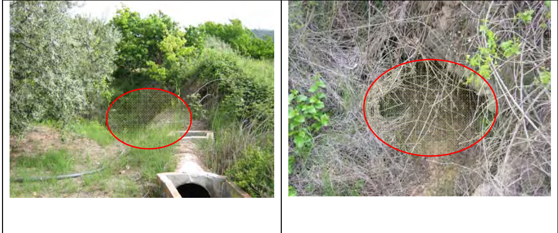
Figura 3: Fotografia de les obres de pas per sota la sèquia de reg.
