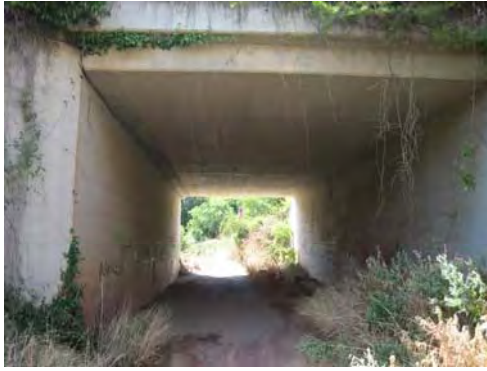
Figura 2: Esquerra Obra de pas sota la C-14 (B=5.7 h=4). Dreta Obra de captació (pou de profunditat 5.3 m des d'on arranca un col·lector de 2x2)
